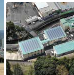
管理棟コミュニティソーラー Community solar panel installation in management block
